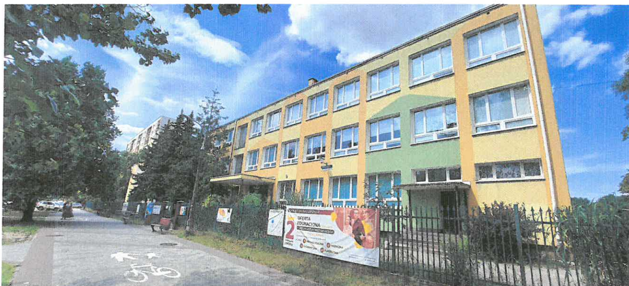
Rys.1 Budynek Szkoły podstawowej nr 3
