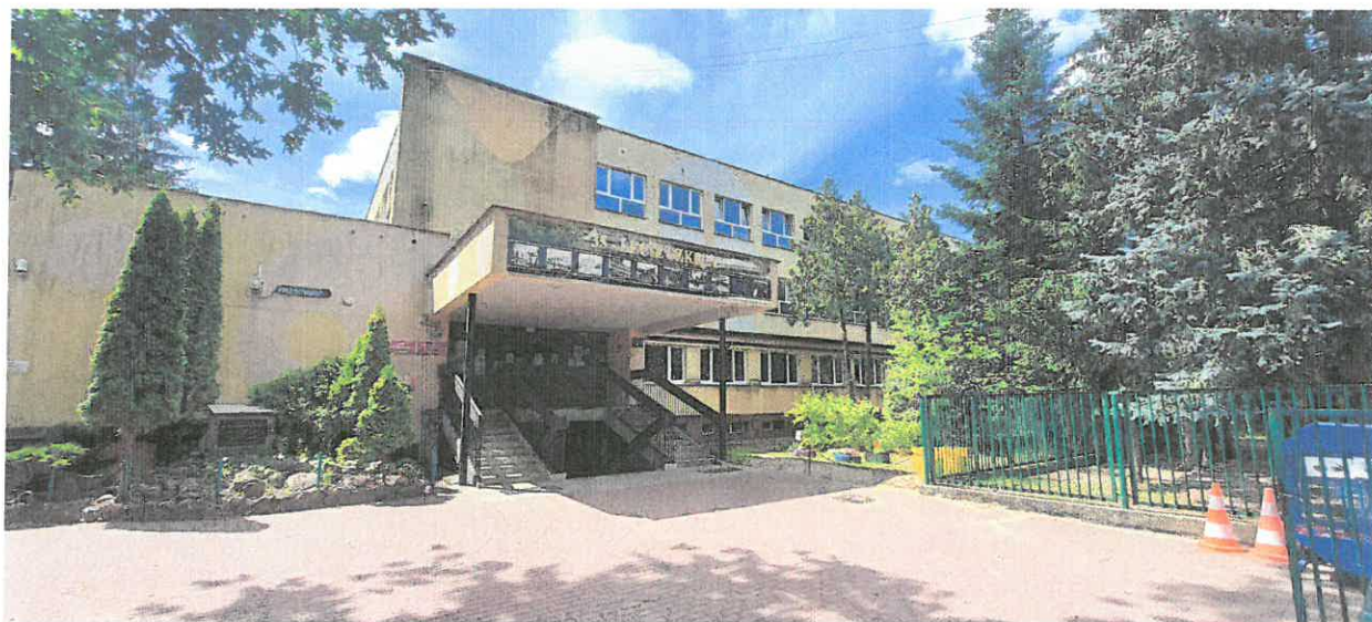
Rys.2. Budynek Szkoły Podstawowej nr 7
