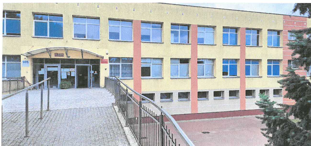
Rys.3. Budynek Szkoły Podstawowej nr 8
