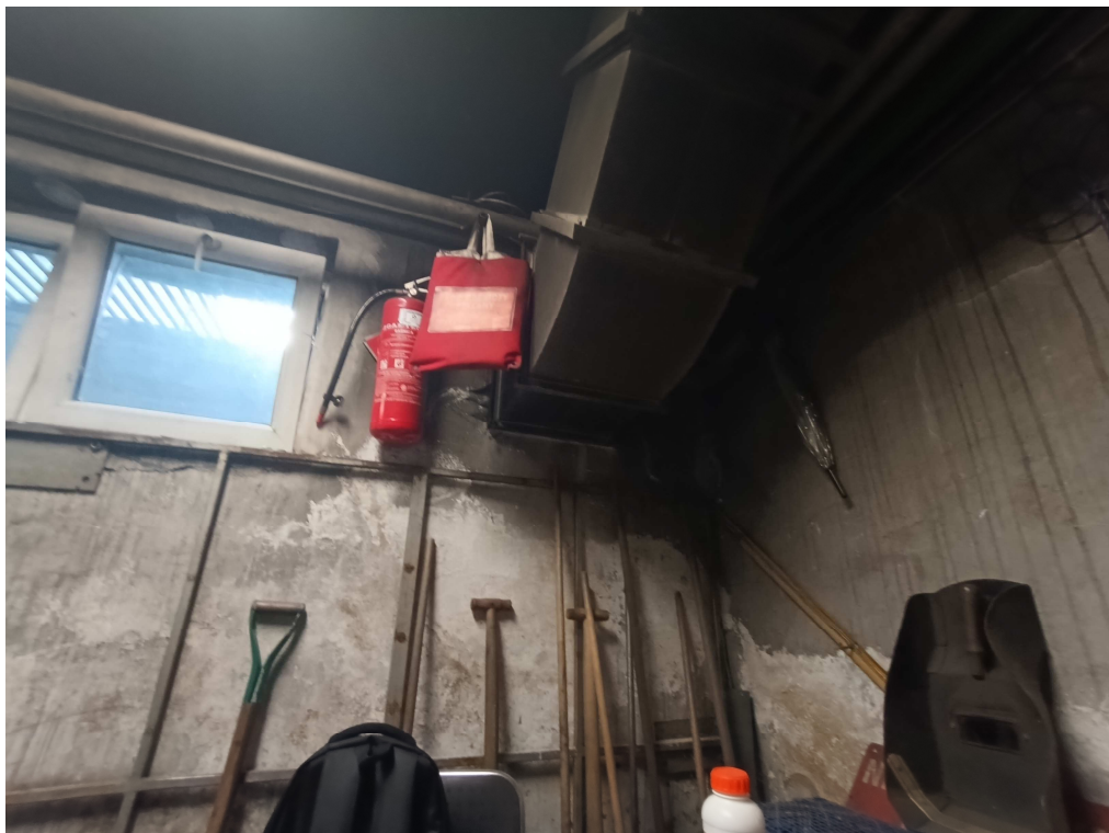
Kanał nawiewny do kotłowni
