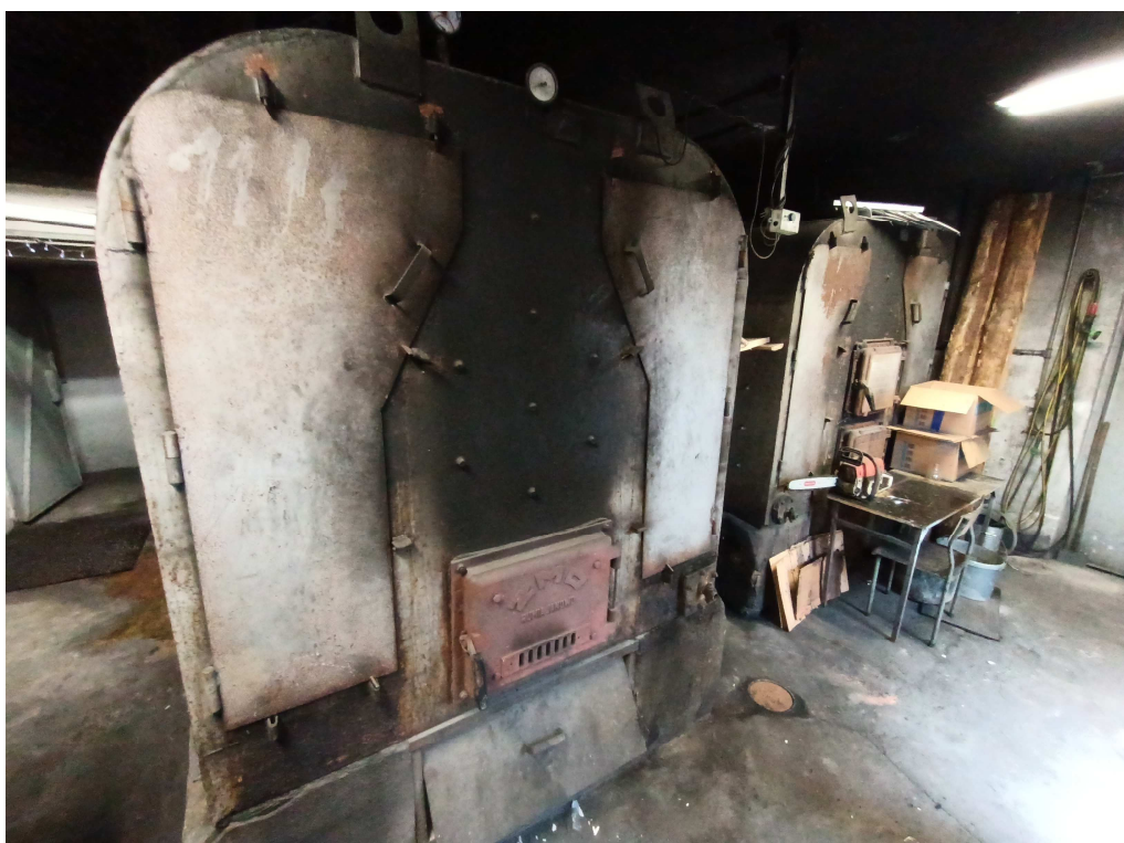
Istniejące kotły na paliwo stałe
