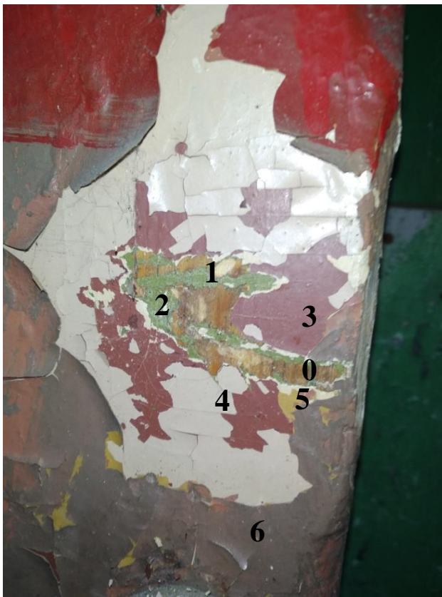
Odkrywka PM_10 Miejsce wcześniejszego odspojenia się warstw malarskich.
