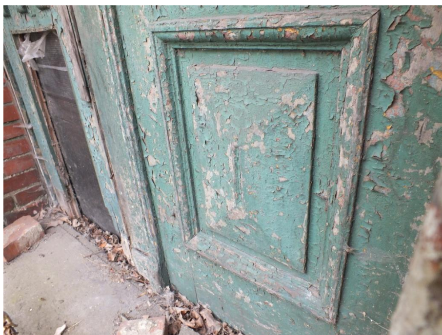
Fot. 6. Mokre, ul. Bursztynowa, elewacja północna, fragment oryginalnych drzwi, widoczna tutaj dolna płycina prawego skrzydła i brak płyciny w drugim skrzydle.
