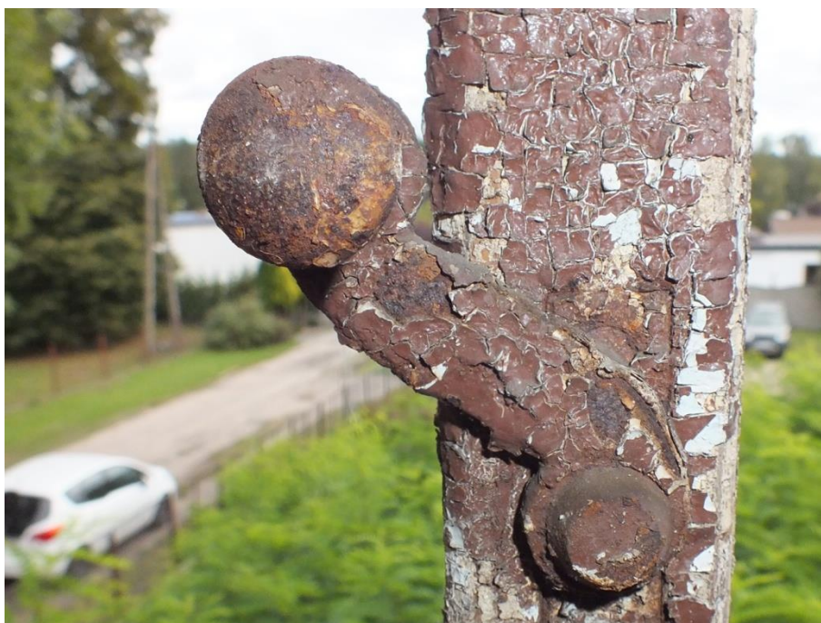
Fot. 5. Mokre, ul. Bursztynowa , elewacja wschodnia, stan zachowania okuć w jednym z okien na piętrze budynku.
