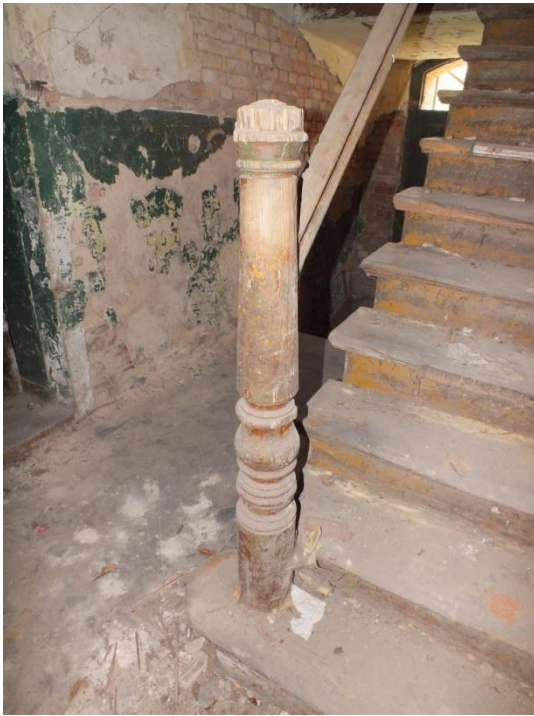
Fot. 9,10. Mokre, ul. Bursztynowa, wnętrze budynku, słupki początkowy (po lewej) i pośredni (po prawej) schodów.
