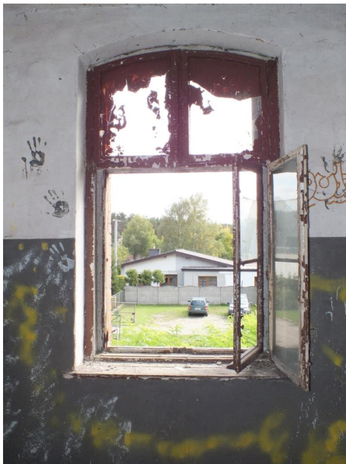
Fot. 3. Mokre, ul. Bursztynowa, elewacja wschodnia, jedno z okien w pomieszczeniu na piętrze, widoczny tutaj ubytki brak skrzydeł okiennych, spękanie i znaczne ubytki warstwy malarskiej.
