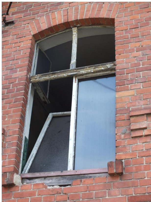
Fot. 1 Mokre, ul. Bursztynowa, elewacja północna, okno klatki schodowej z widocznymi ubytkami warstwy malarskiej, oszklenia i elementów konstrukcyjnych okna, a także detalu.
