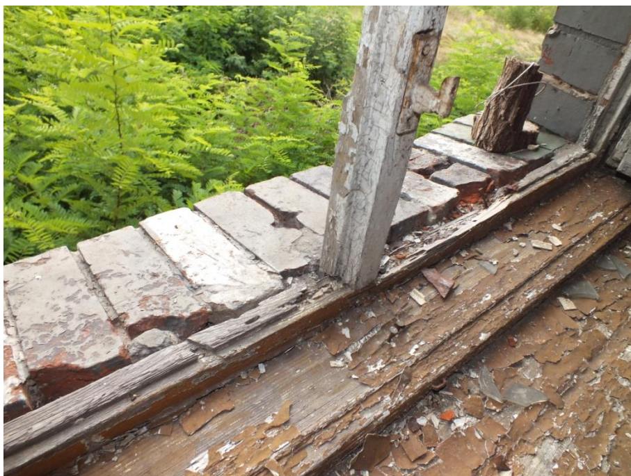
Fot. 4. Mokre, ul. Bursztynowa, elewacja wschodnia, fragment okna, widoczny tutaj stan zachowania elementów okna, a także warstwy malarskiej.
