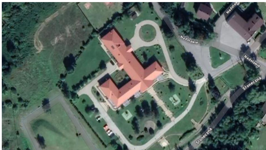
Zdjęcie poglądowe – konstrukcja dachu
