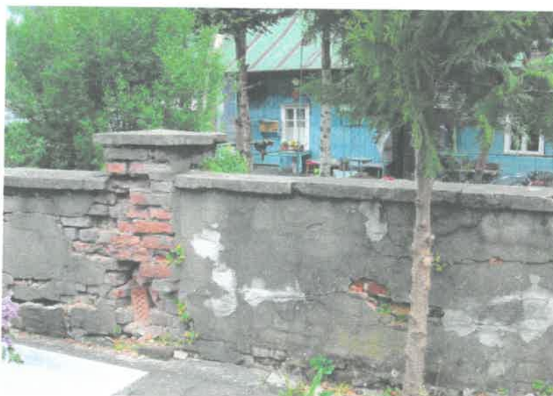
Fot. nr 4. Widoczne zniszczenia muru ogrodzeniowego.
