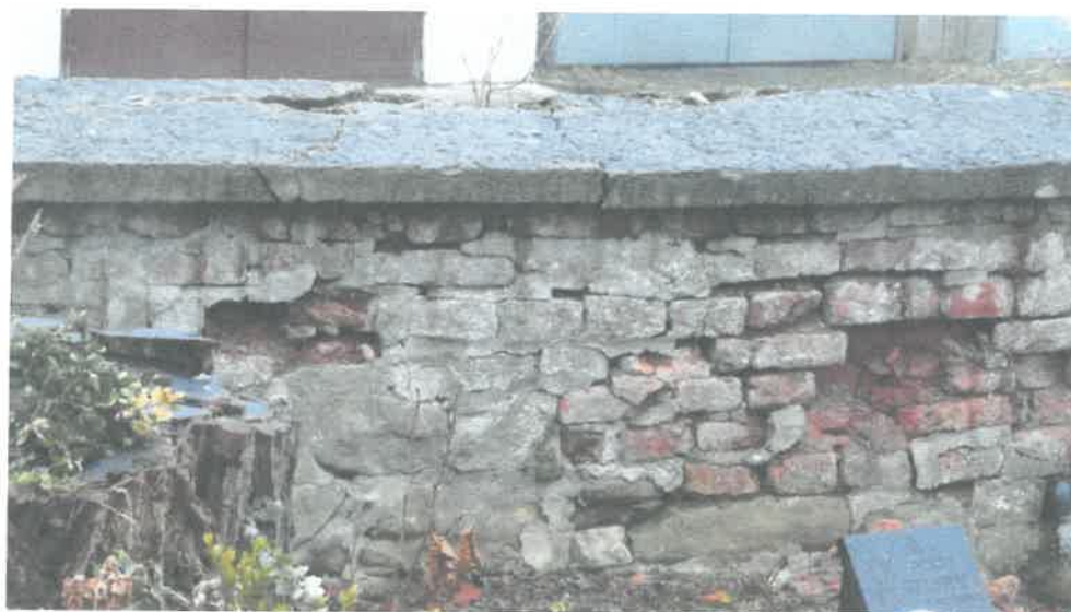
Fot. nr 1. Fragment muru wykonanego z cegły.
