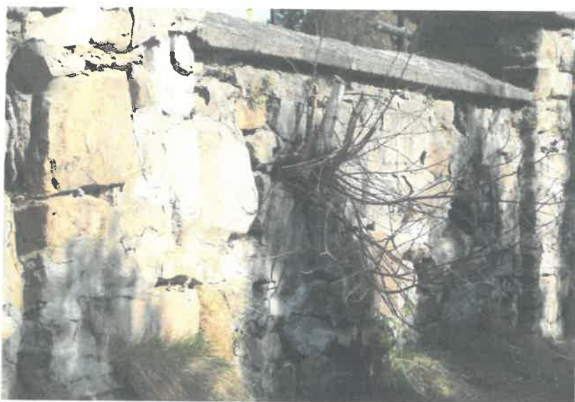
Fot. nr 9. Widoczne zniszczenie muru spowodowane rosnącymi drzewami.
