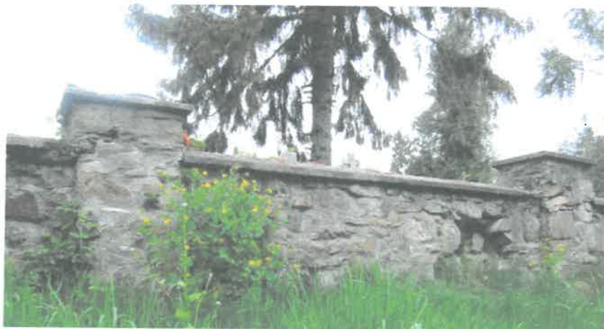
Fot. nr 6. Widoczne zniszczenia muru ogrodzeniowego.
