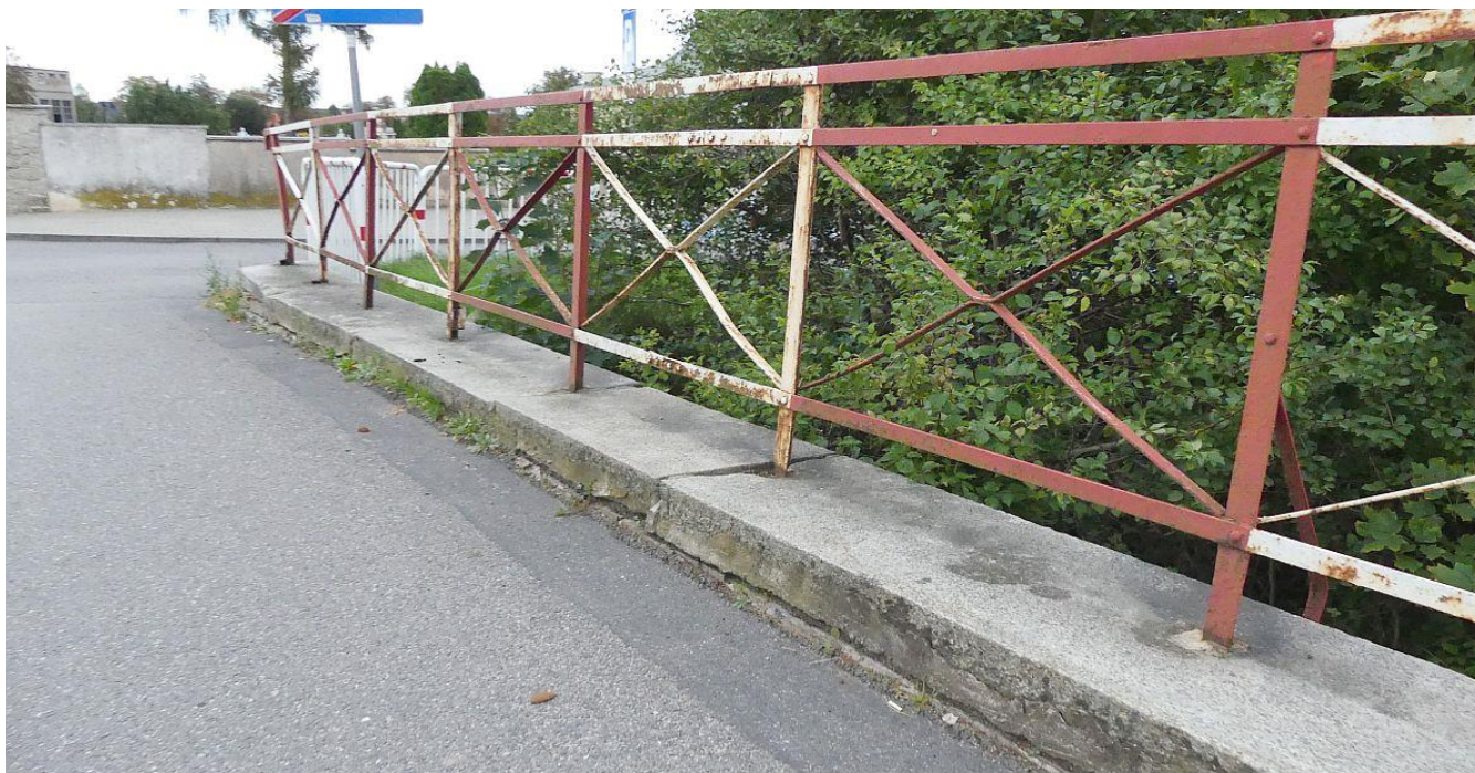
Fot. 12 Widok balustrad wiaduktu
