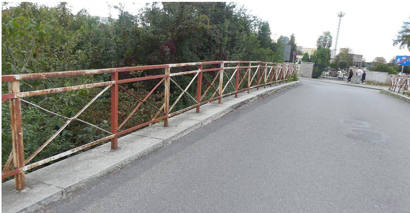
Fot. 11 Widok balustrad wiaduktu
