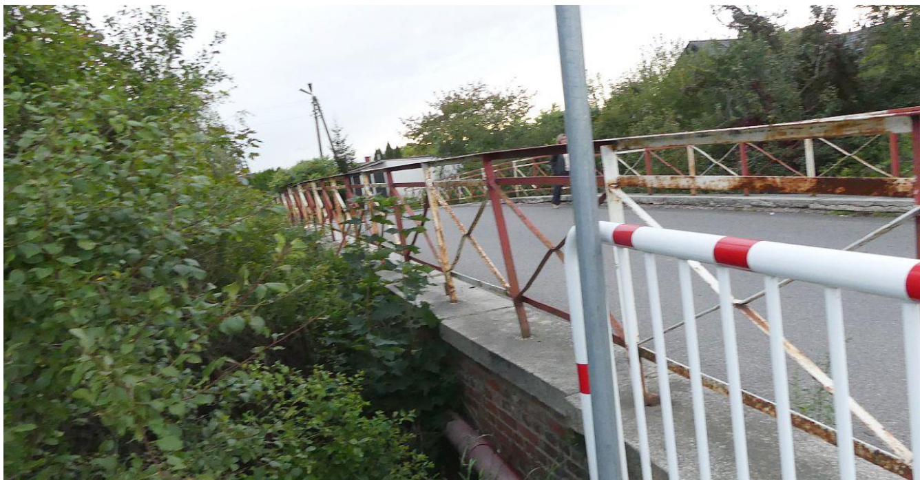
Fot. 3 Widok wiaduktu z boku
