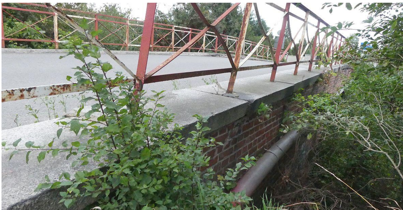
Fot. 4 Widok wiaduktu z boku
