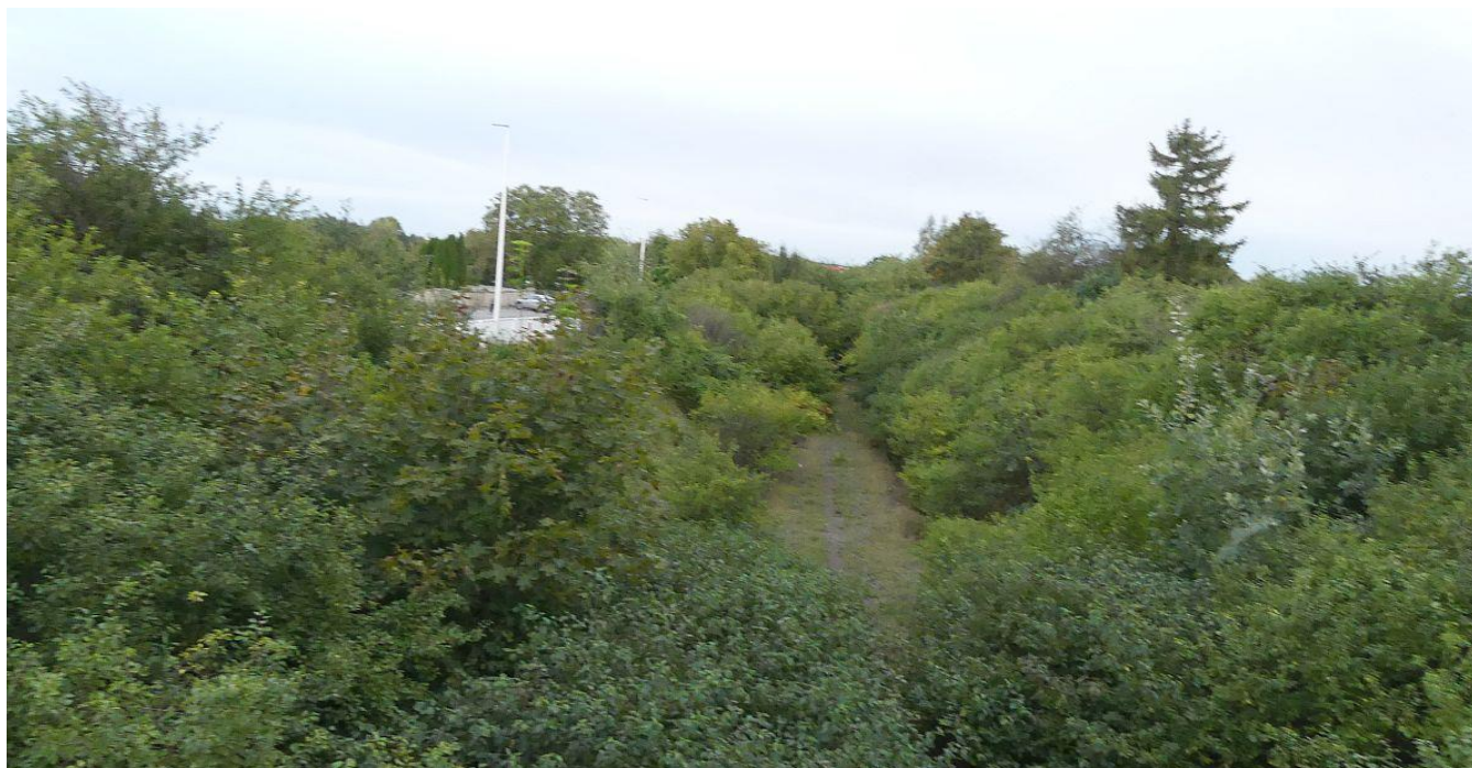
Fot. 5 Widok z wiaduktu
