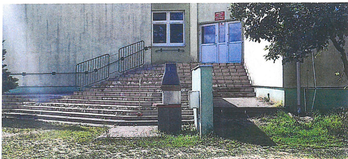
Widok schodów bieg północny
