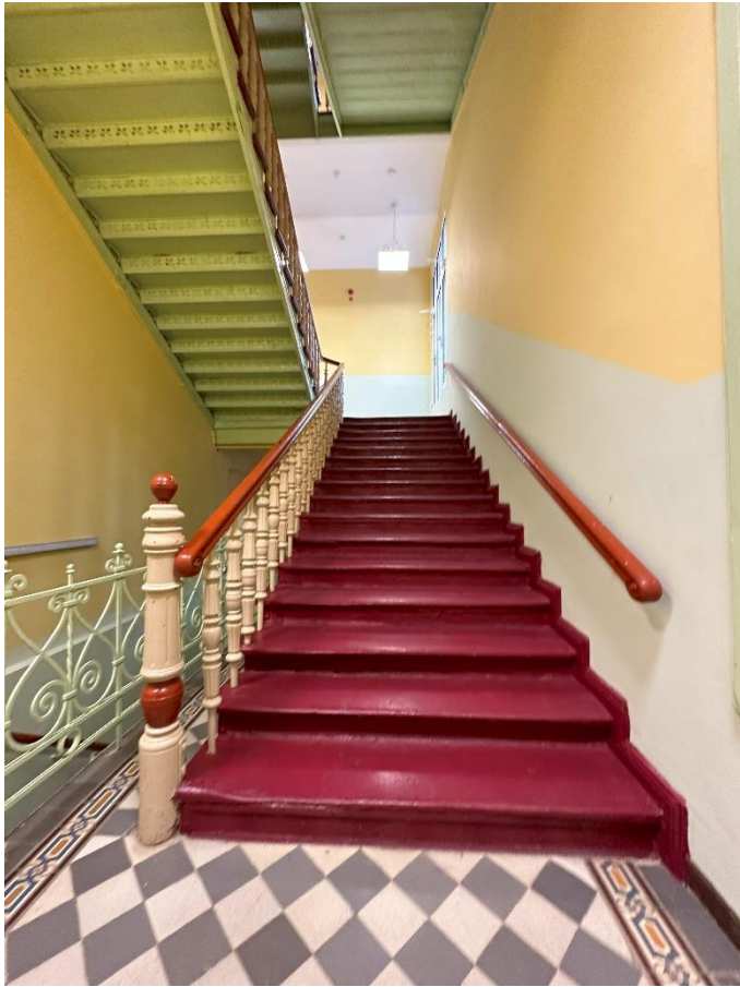
Fot. 11 Klatka schodowa narożna (K2) –parter, stan istniejący
