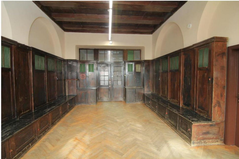
FOT. 18 – IV kondygnacja – korytarz – widok ogólny w kierunku północnym.
