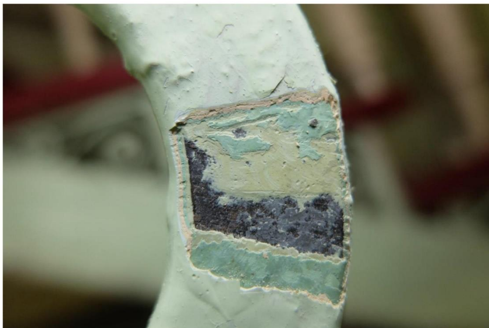
FOT. 5 - Klatka schodowa narożna, parter – balustrada nad schodami do piwnic, fragment - odkrywka.
