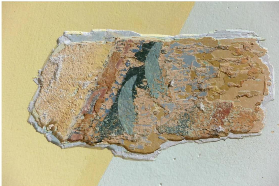
FOT. 27, 28 - Klatka schodowa narożna, III kondygnacja, ściana południowa, fragment ←
