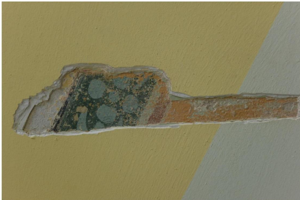
FOT. 19, 20 - Klatka schodowa narożna, parter, ściana południowa – dekoracja malarska ściany – fryz dekoracyjny wieńczący pas lamperii. ←
