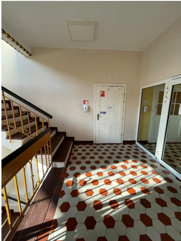
Fot. 5 Klatka schodowa główna (K1) –II piętro, stan istniejący
