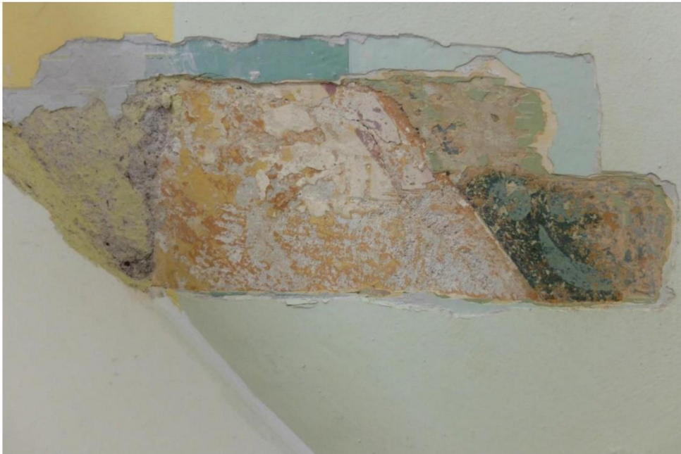
FOT. 25, 26 - Klatka schodowa narożna, III kondygnacja, ściana wschodnia, fragment – lokalizacja odkrywki i fragment odstąpiętego fryzu zamykającego lamperię biegnącą skosem wzdłuż skosu stropu. ←
