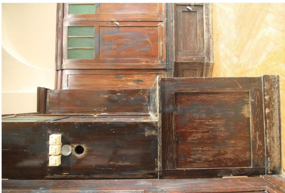
FOT. 20 - IV kondygnacja – szafy ścian korytarza, fragment. ←
