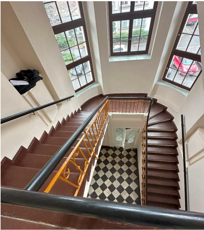
Fot. 3 Klatka schodowa główna (K1) –I piętro, stan istniejący
