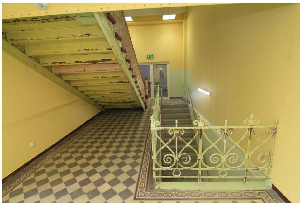
FOT. 2 - Klatka schodowa narożna, parter – widok ogólny w kierunku zachodnim.
