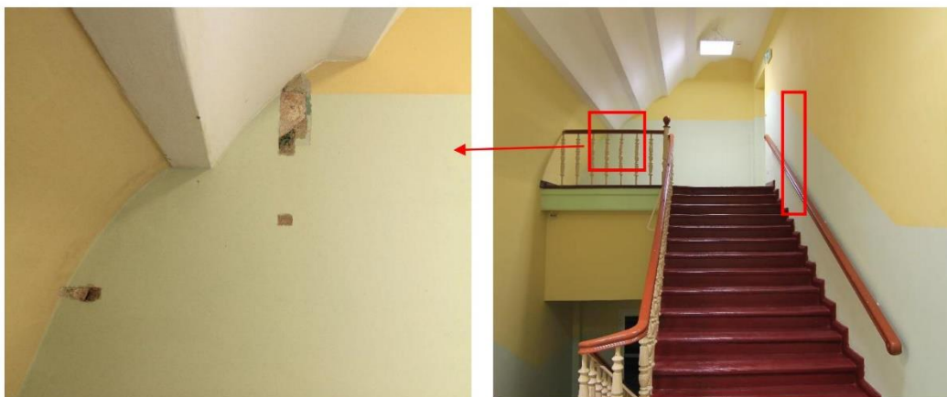
III kondygnacja, widok ogólny z półpiętra, detal.
