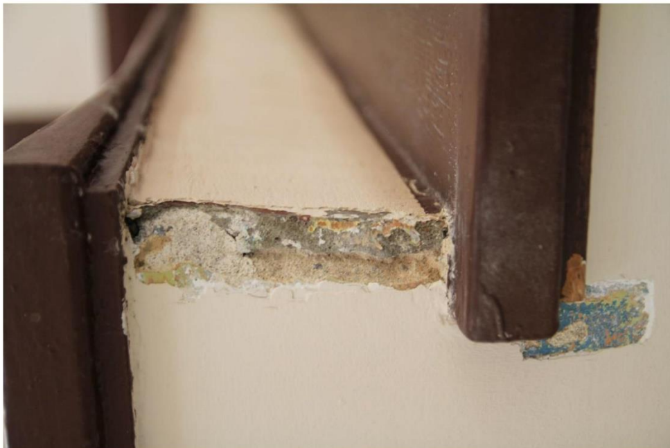
FOT. 9, 10 - detal fot. 2 – stopnie schodów, fragmenty w miejscach odkrywek. Odstonięta powierzchnia gładzi okładziny cementowej. Nałożone stopnice schodów drewniane. Powierzchnia okładziny cementowej malowana wfonie. ←
