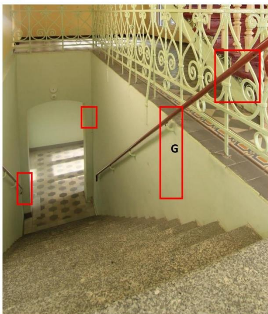
Parter – zejście do piwnicy
