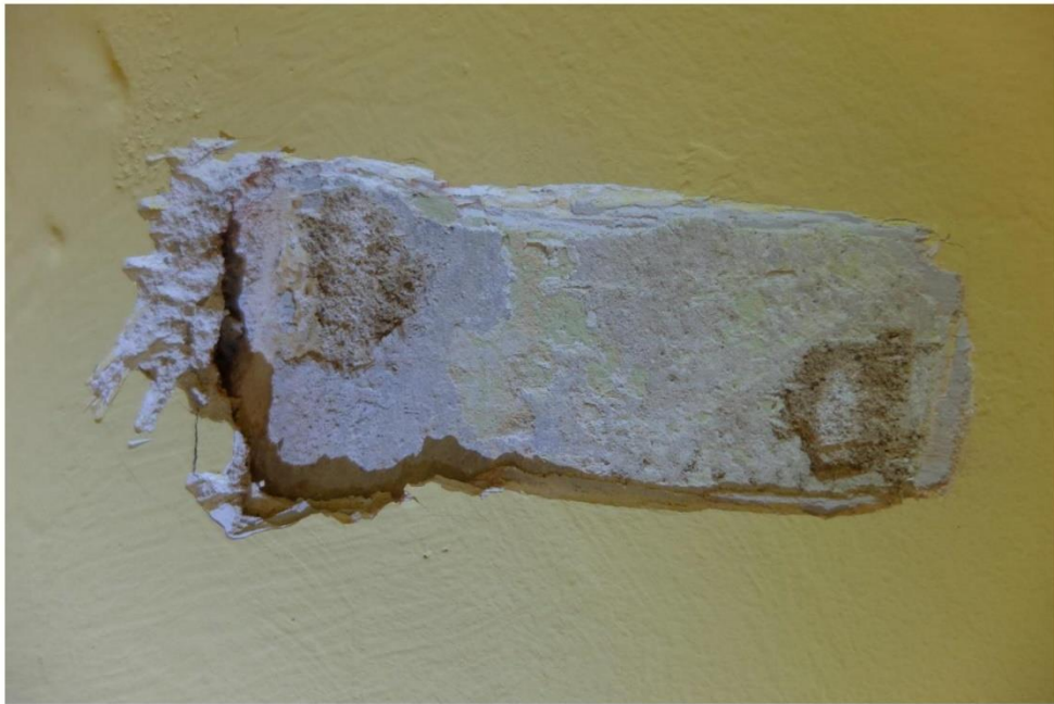
FOT. 23 - Klatka schodowa narożna, parter – tynk ściany pod stropem ←
