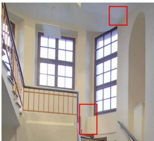
Półpiętro I / II kondygnacja
