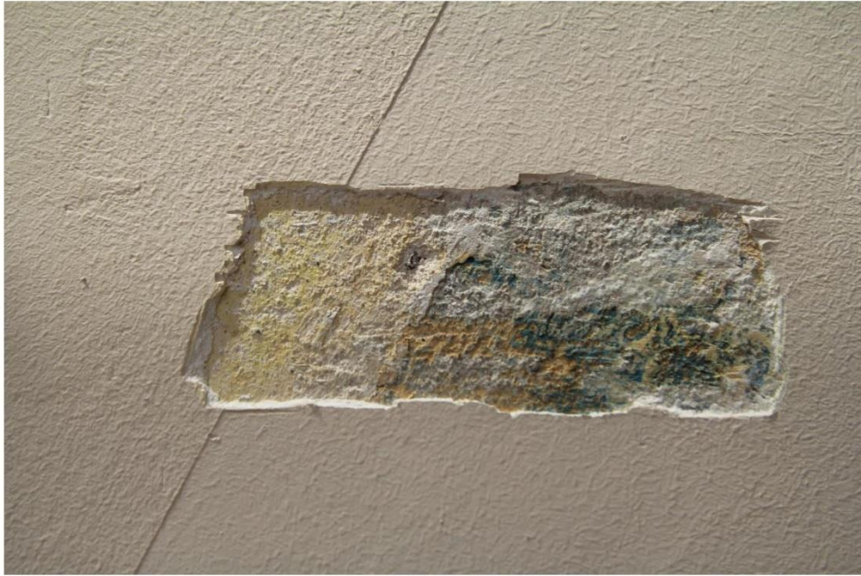
FOT. 17 - III kondygnacja, ściana wschodnia, fragment – detal fot. 16 ←
