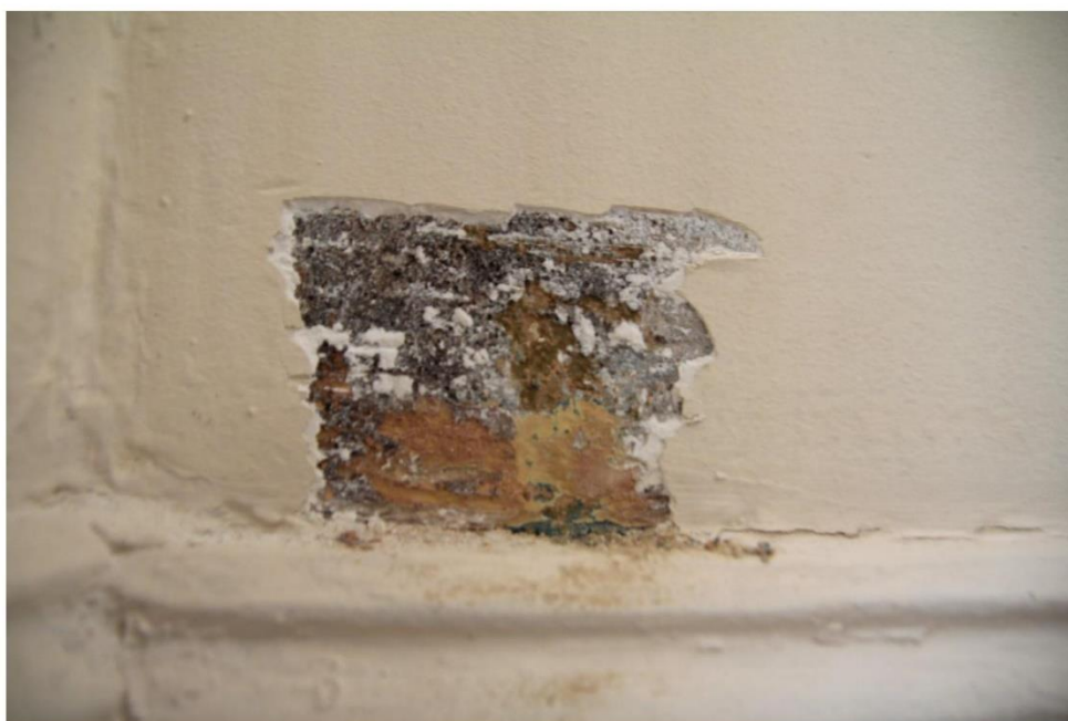
FOT. 11, 12 – Półpiętro I/II kondygnacji, ściana południowa, fragment po wykonaniu odkrywek – widok ogólny i fragment
