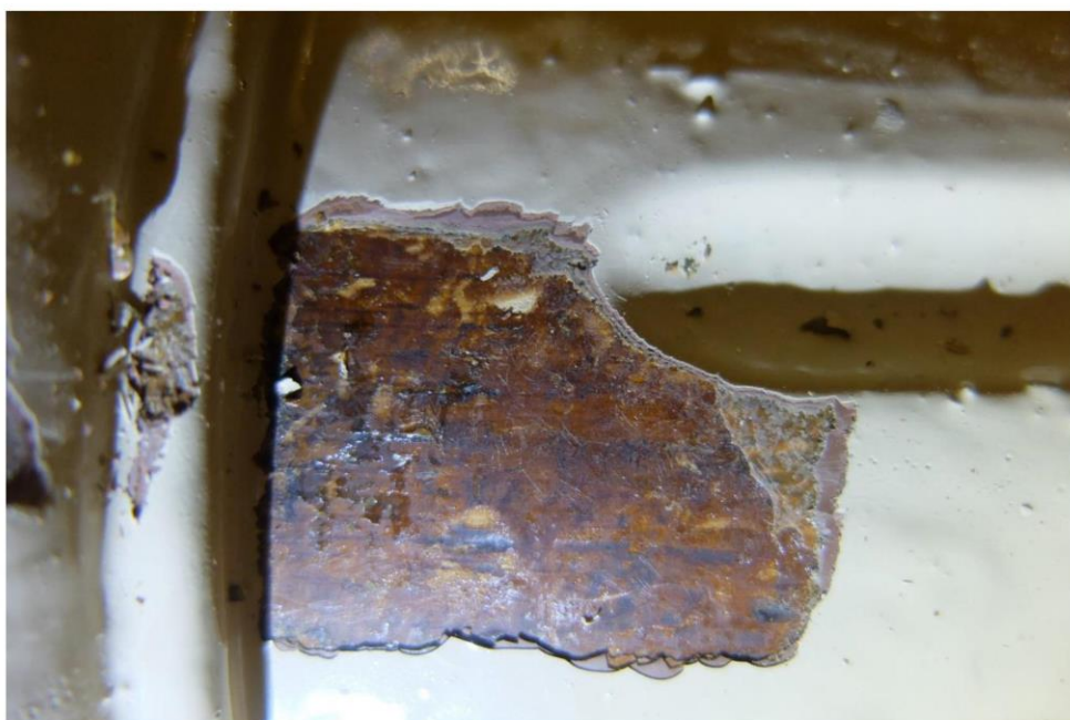
FOT. 13, 14 - Klatka schodowa narożna, parter – słupek początkowy balustrady schodów, drewno lakierowane, wlotnie malowane farbami olejnymi.
