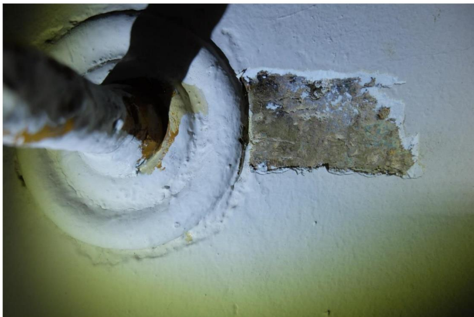
FOT. 15 – II kondygnacja, ściana wschodnia – detal fot. 13.
