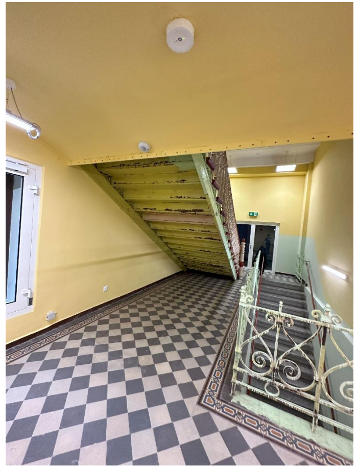
Fot. 12 Klatka schodowa narożna (K2) –parter, stan istn.
