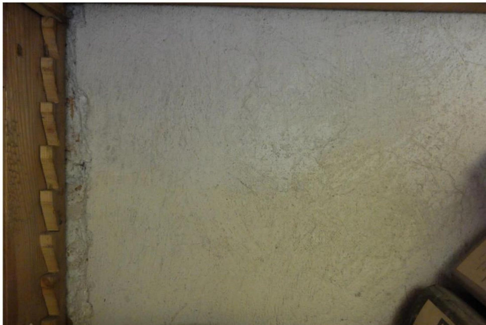
FOT. 11, 12 - Klatka schodowa narożna, parter – szafa węgkowa, widok ogólny wnętrza i fragment.
