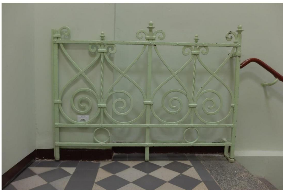
FOT. 6 - Klatka schodowa narożna, parter – drzwiczki stalowe w przejściu na schody prowadzące do piwnic budynku.
