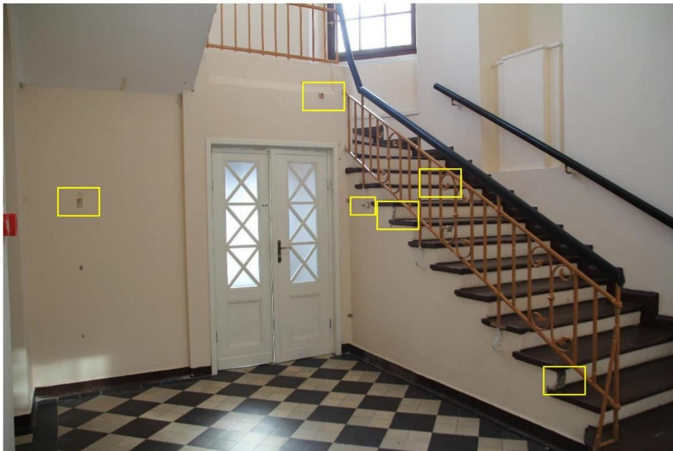
FOT. 2 - Główna klatka schodowa, parter – ściana półczkowa pierwszego biegu schodów, drzwi w przejściu do sieni wejścia do budynku. Widok ogólny po wykonaniu odkrywek.
