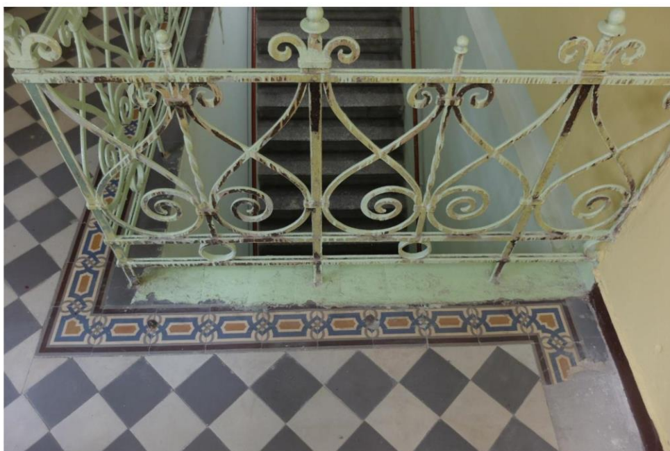
FOT. 4 - Klatka schodowa narożna, parter – balustrada nad schodami do piwnic budynku. W posadzce widoczne stalowe bolce mocowania usuniętej drewnianej przegrody zamykającej przestrzeń klatki schodowej.
