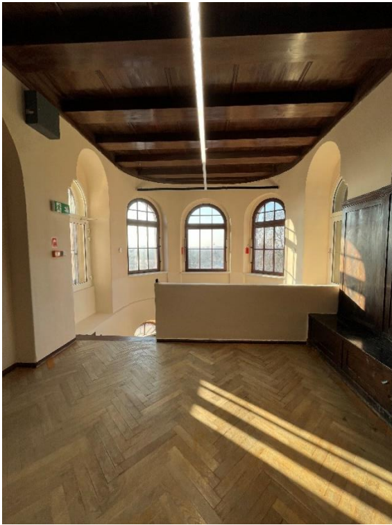
Fot. 7 Klatka schodowa główna (K1) –III piętro, stan istniejący
