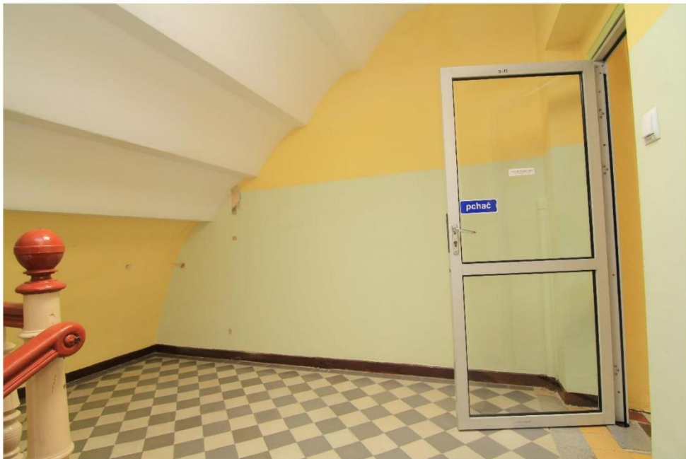
FOT. 24 - Klatka schodowa narożna, III kondygnacja, ściana wschodnia, widok ogólny.
