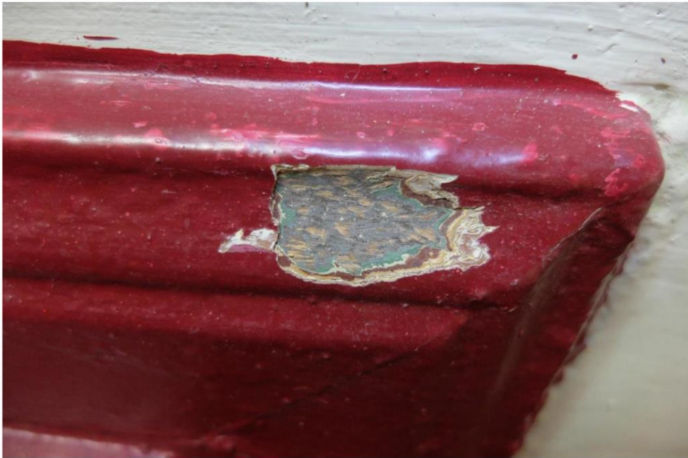
FOT. 17, 18 – Drewniane stopnice schodów, fragment.
