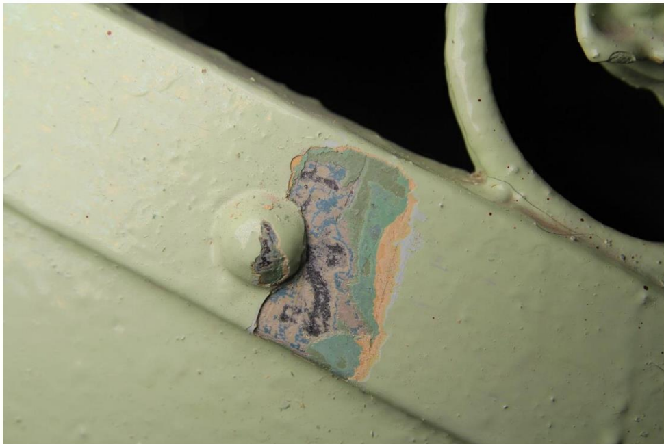
FOT. 16 – Stalowa konstrukcja schodów, fragment - odkrywka
