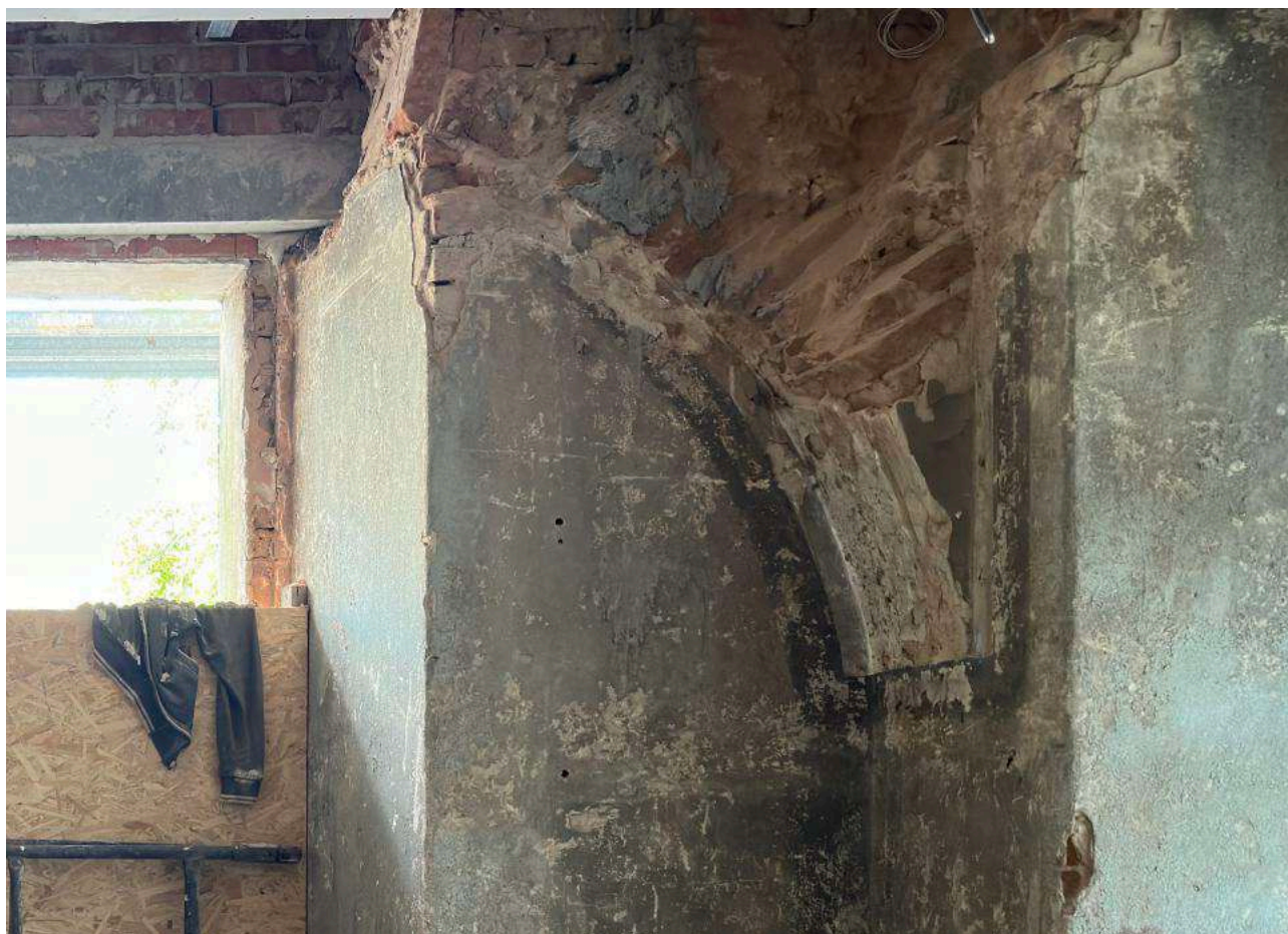
Fot. 20. Relikt sklepienia B przed rozpoczęciem prac.
