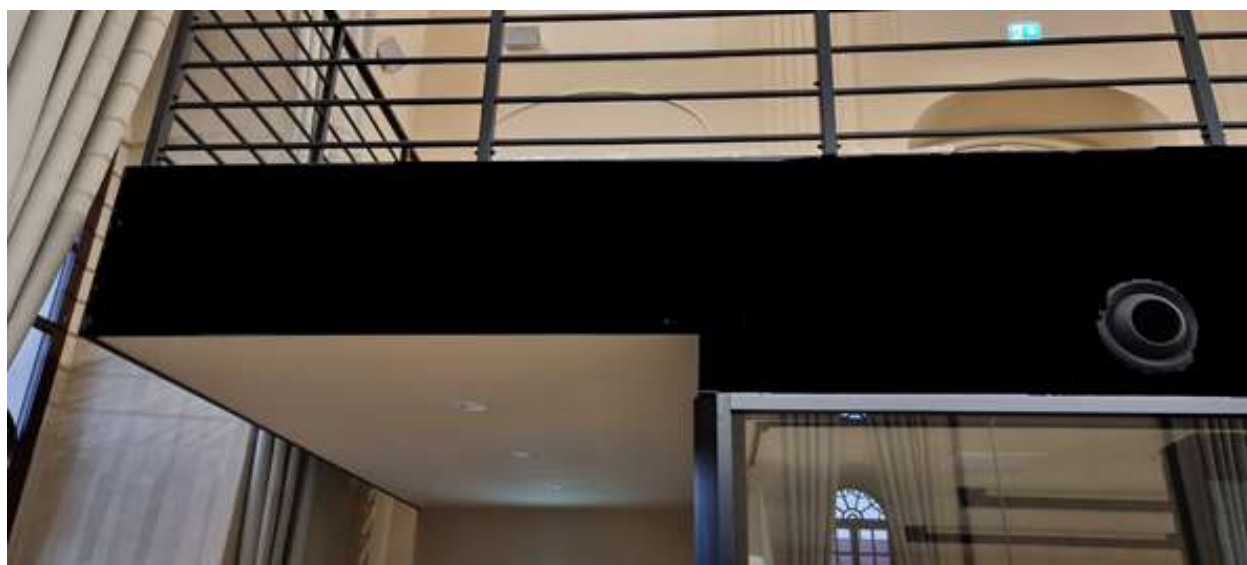
widok fragmentu obudowy balkonu – stan projektowany
