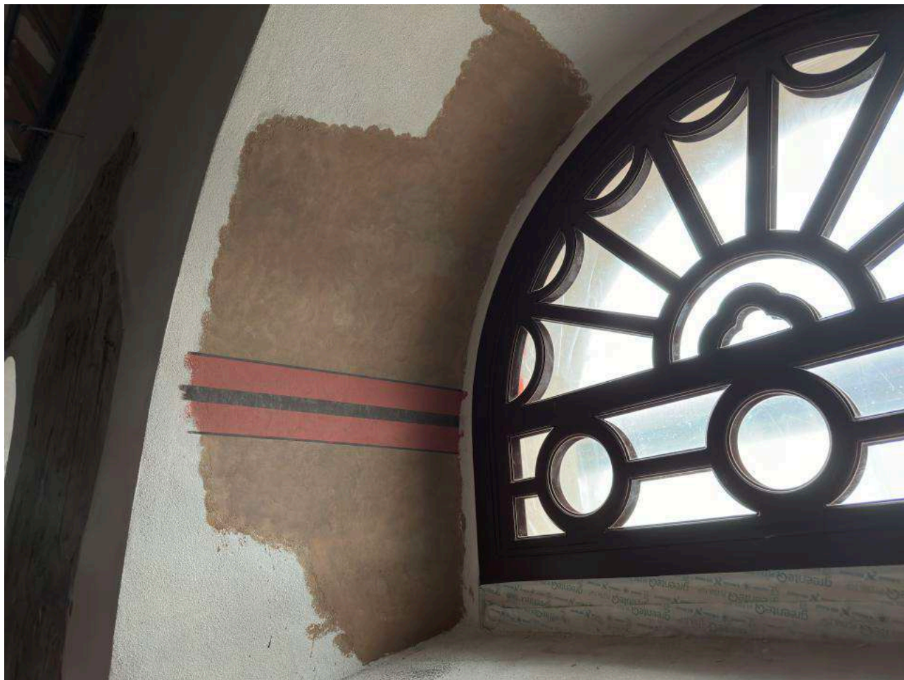
Fot. 9. Opaska w trakcie prac rekonstrukcyjnych - stan przed zamalowaniem
