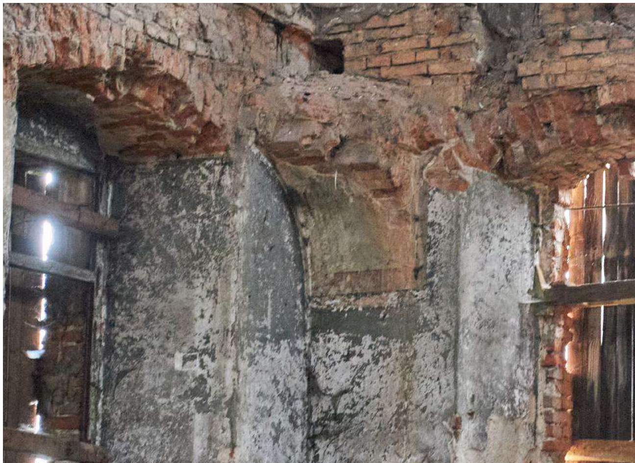
Fot. 22. Relikt sklepienia A z widocznymi paskami - stan przed rozpoczęciem prac
