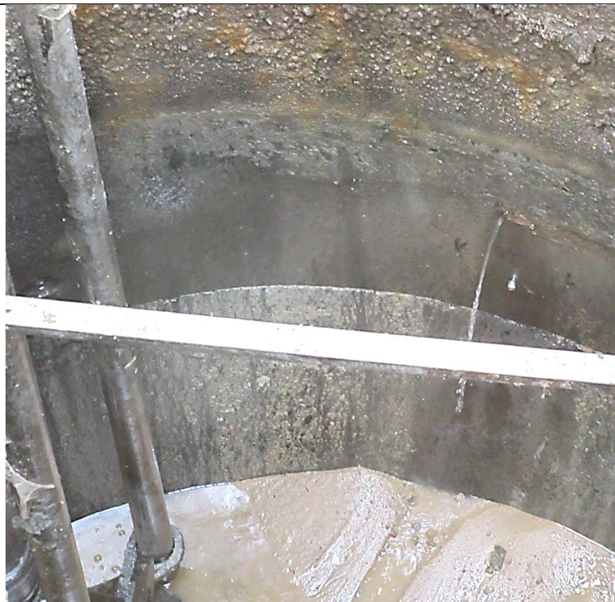
Wyraźnie zarysowana granica pomiędzy betonem zdegradowanym a nieuszkodzonym. Dodatkowo stróżka wody w przecieku przez płaszczyznę.
