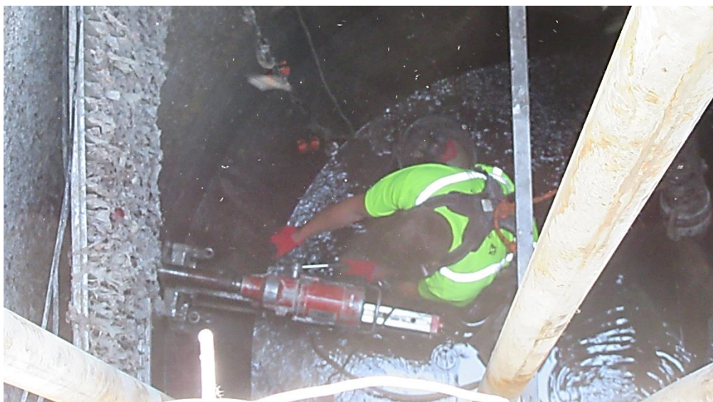
Proces pobieranie próbki rdzeniowej nad dnem.
