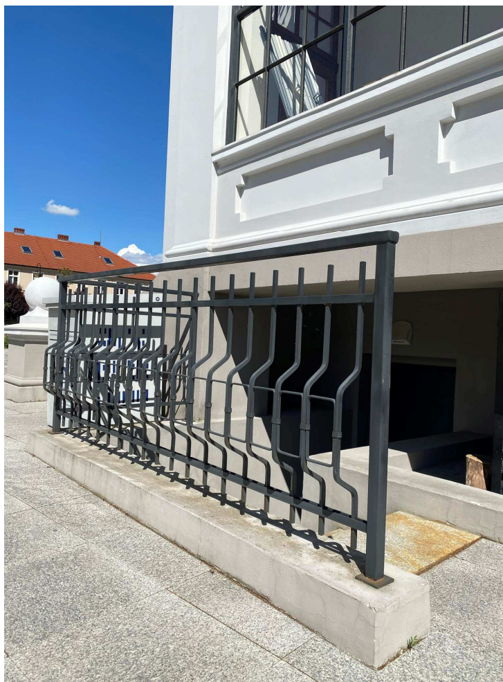
Sposób montażu i wygląd słupka krańcowego
