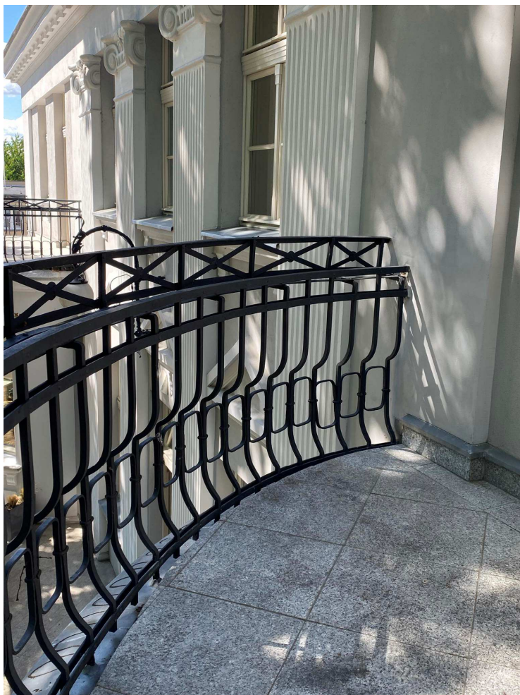
Balustrada istniejącą balkonu elewacji tylnej
