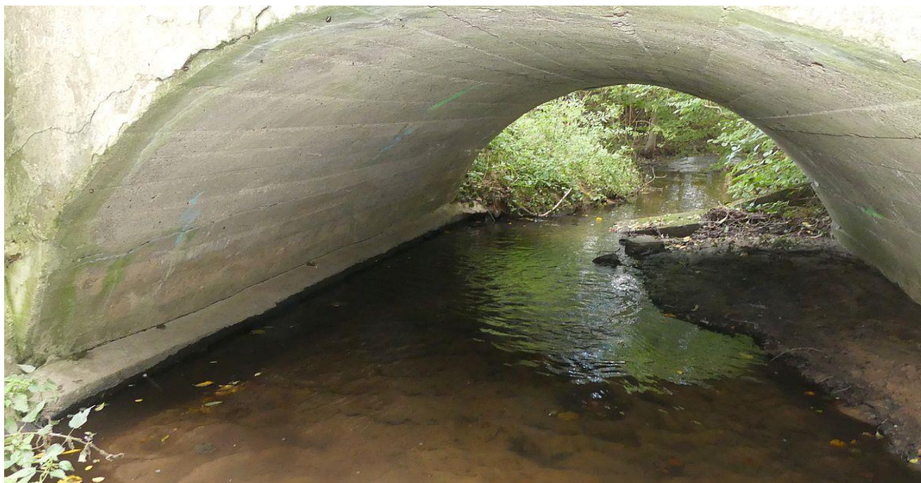
Fot. 6 Widok przestrzeni podmostowej
