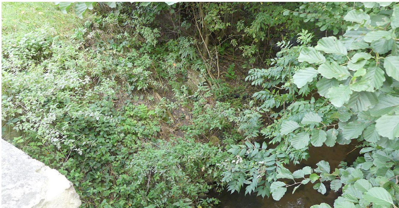
Fot. 5 Widok z mostu na ciek
