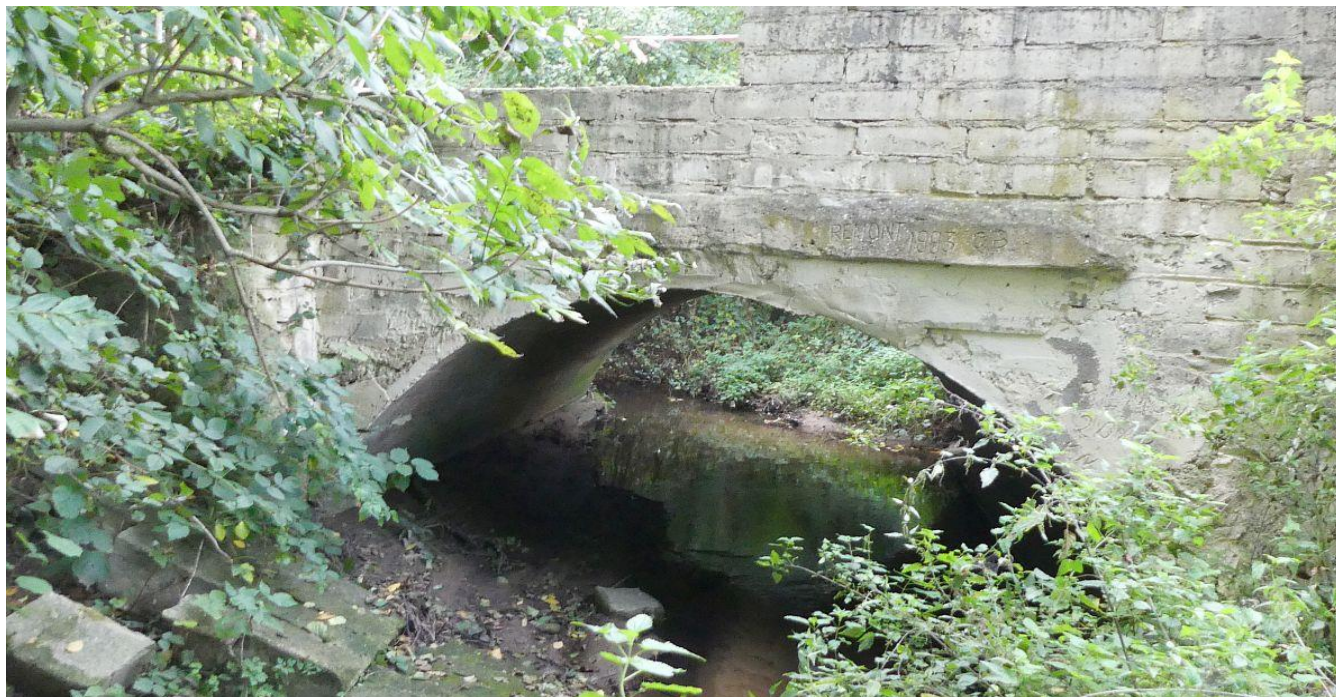
Fot. 3 Widok mostu z boku
