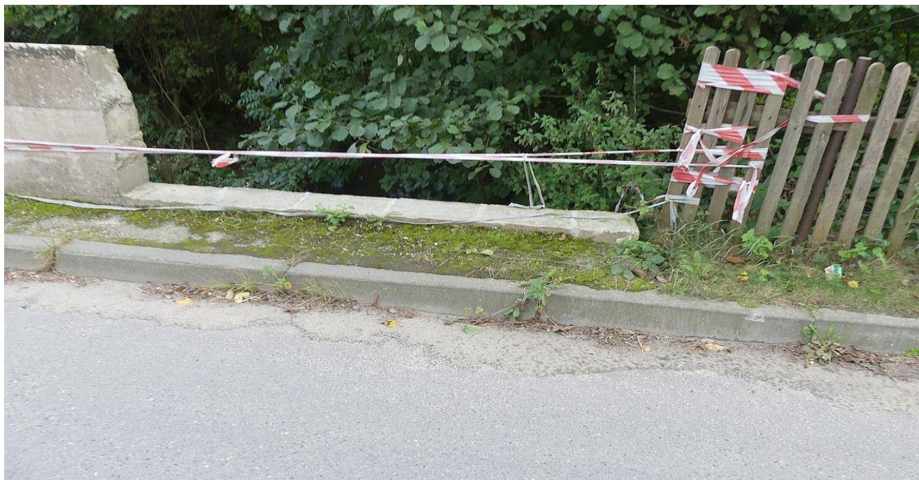
Fot. 11 Widok balustrad mostu
