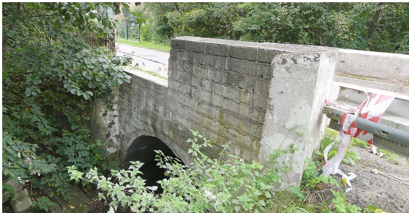
Fot. 4 Widok mostu z boku
