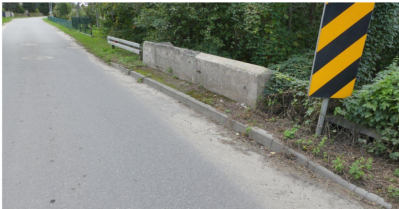
Fot. 12 Widok balustrad mostu
