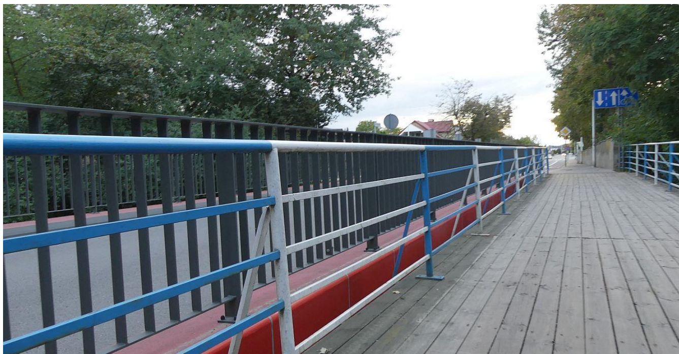
Fot. 12 Widok balustrad wiaduktu
