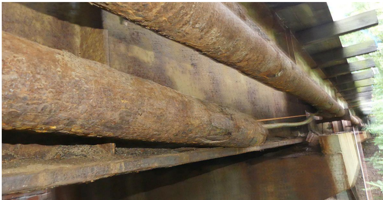
Fot. 4 Widok wiaduktu z boku
