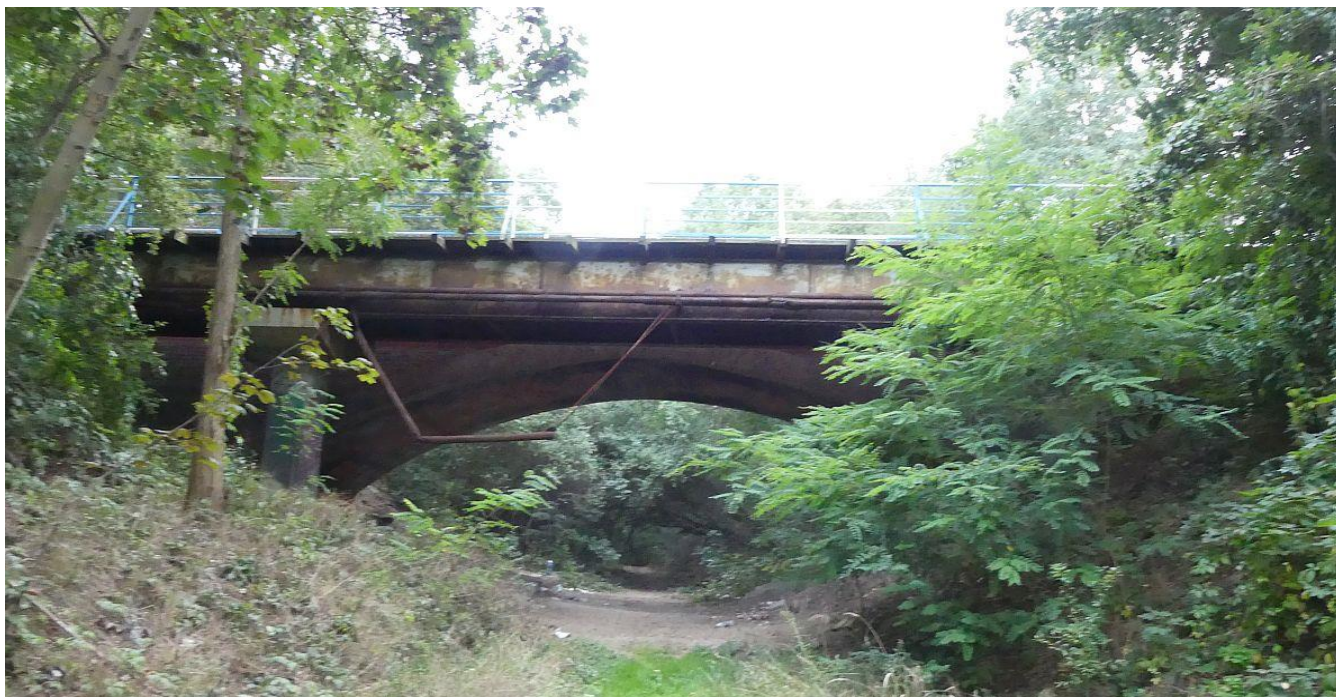
Fot. 3 Widok wiaduktu z boku
